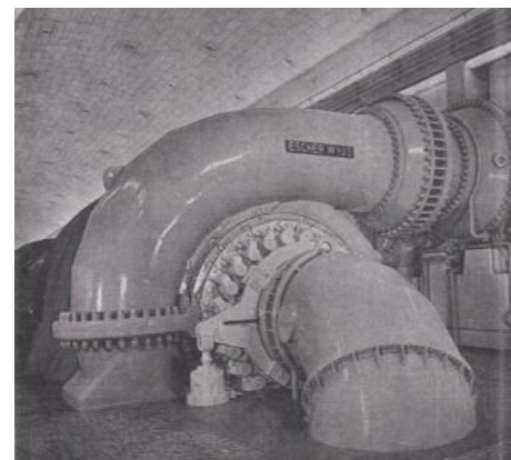
شکل ۴- شمائی از یک توربین آبی فرانسسیس با قدرت بالا
